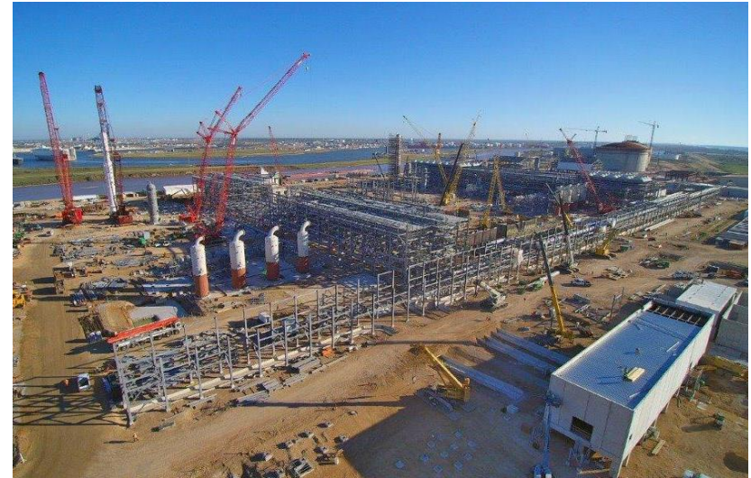
Freeport LNG liquefaction facility construction Source: Freeport LNG
